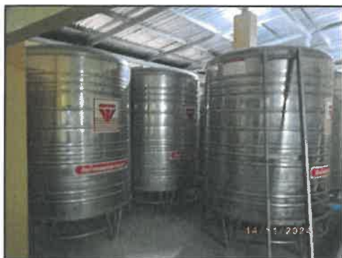
รูปที่ 2-14 จัดให้มีถังสำรองน้ำใช้บนดิน และถังสำรองน้ำใช้ชั้นหลังคา
