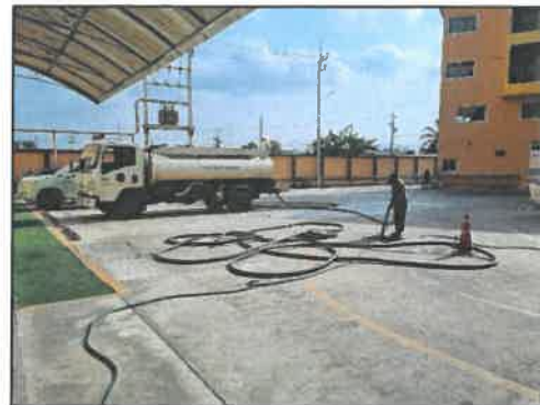
รูปที่ 2-13 ผู้รับเหมามาสูดกากตะกอนออกจากบ่อ เมื่อบ่อเกรอะเต็ม
