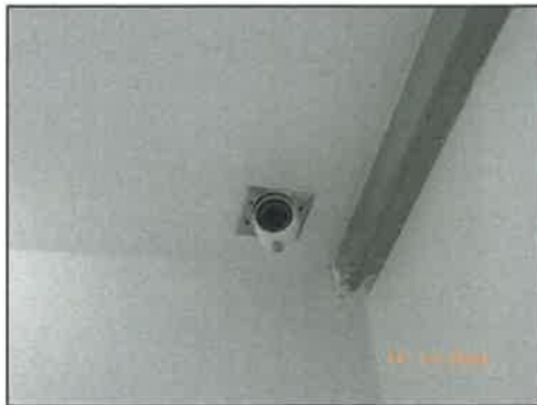
รูปที่ 2-45 ติดตั้งกล้องวงจรปิด CCTV บริเวณทางเข้า-ออกโครงการ และบริเวณจุดอับในทุกๆ ชั้น ภายในอาคาร
