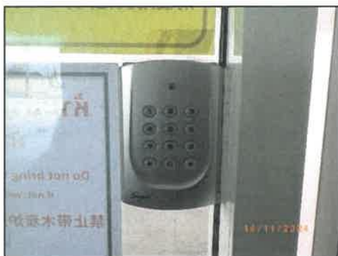
รูปที่ 2-46 ติดตั้งระบบ Key card สำหรับผ่านเข้า-ออก อาคาร
