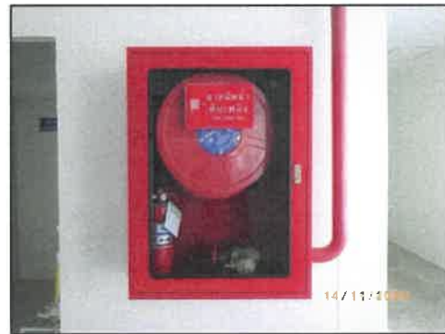
รูปที่ 2-29 ตู้เก็บสายฉีดน้ำดับเพลิงพร้อมอุปกรณ์
